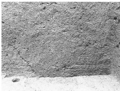
6. トレンチ西壁2号住居の立ち上り状況
