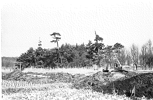
第2図 バックホーによる表土削平
