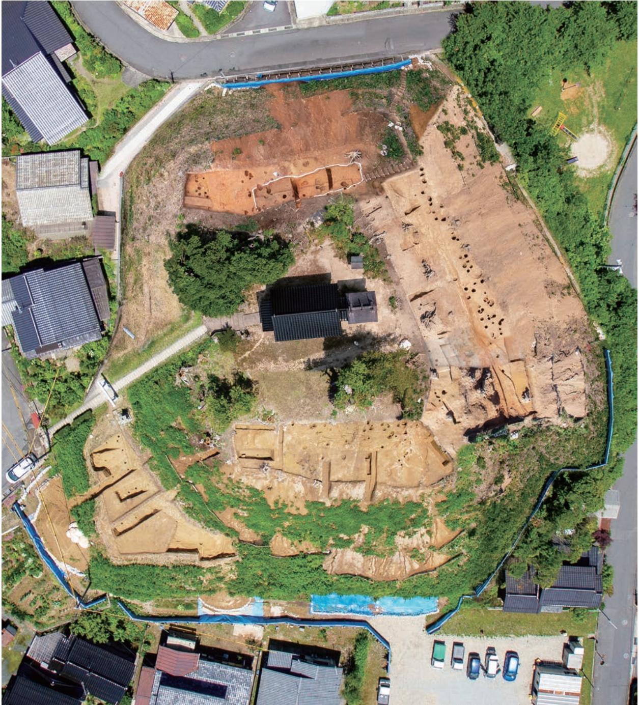
第1次～第4次調査全景（上が北西）
