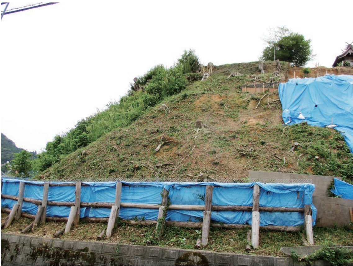
2区 北東側斜面 調査前状況（北東から）
