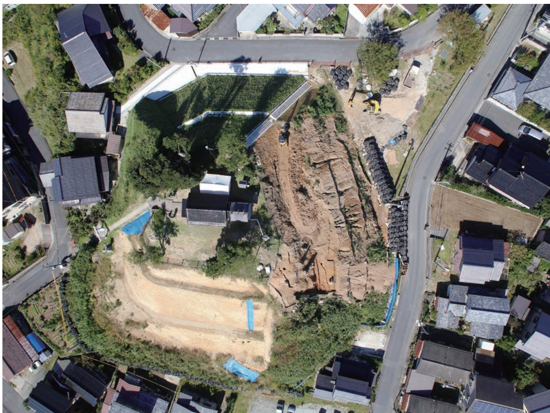
調査位置全景（上が北西）
