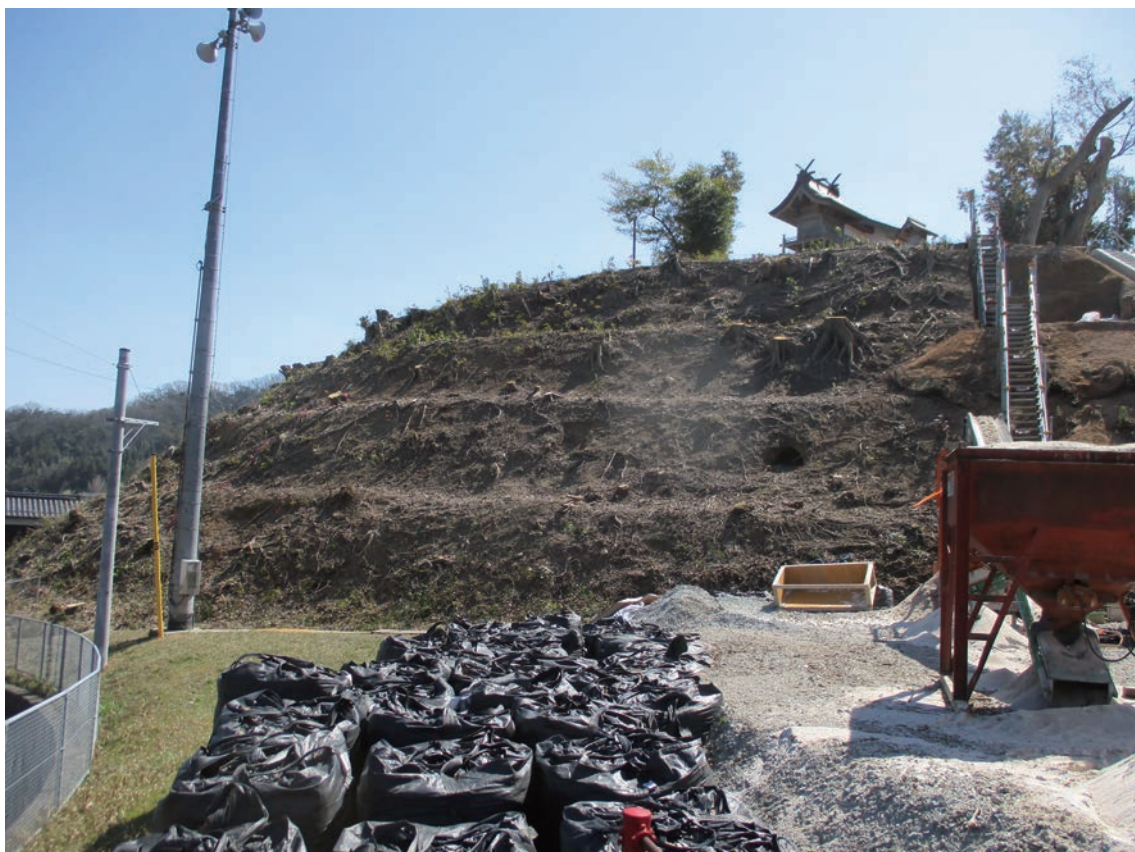
北東側斜面 調査前状況（北東から）
