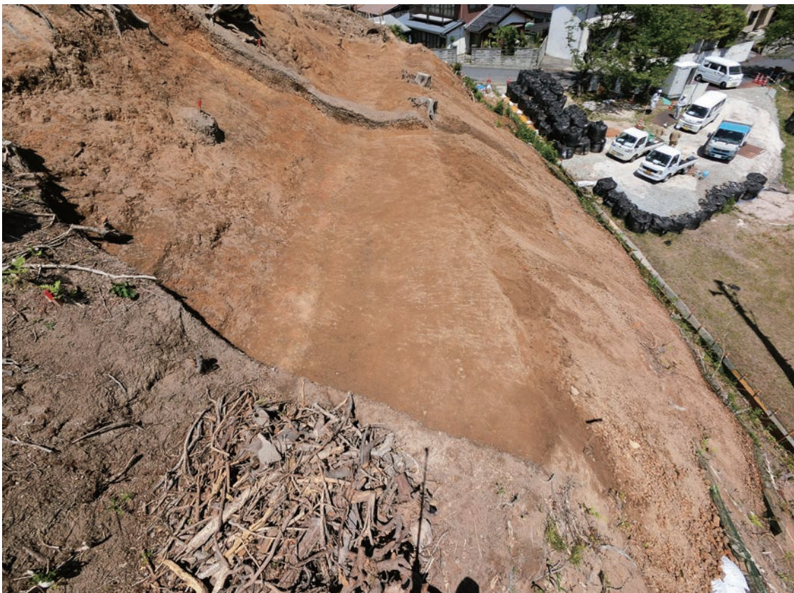
Ⅱ-2期 腰郭9平坦面検出状況（南東から）
