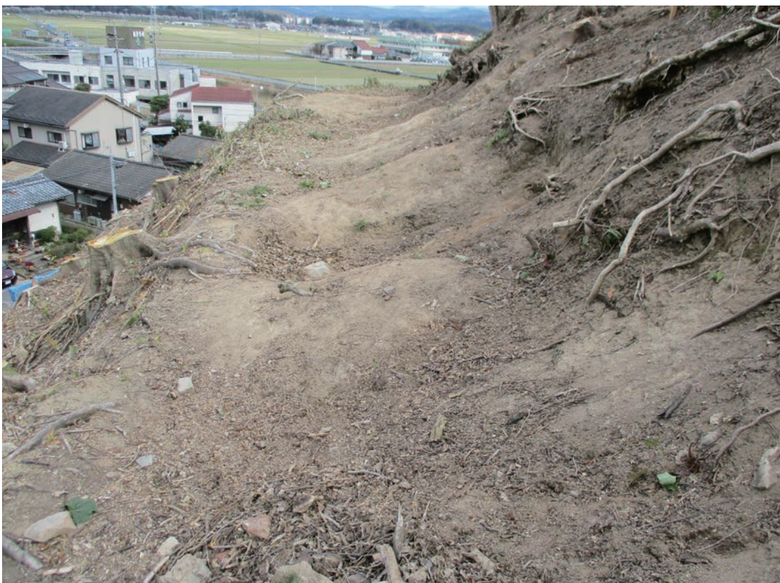
斜面中腹平坦地 調査前状況（北西から）
