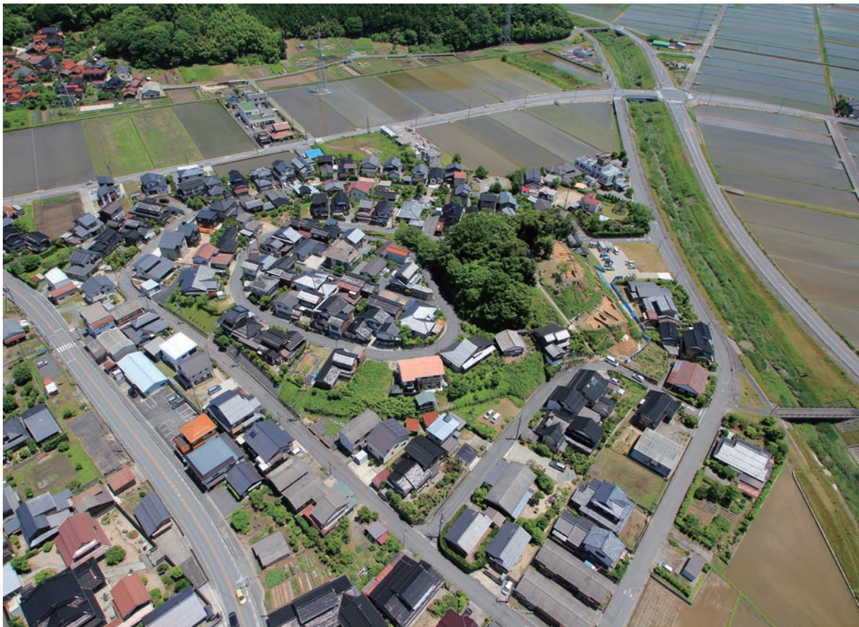
石井要害跡全景（西から）
