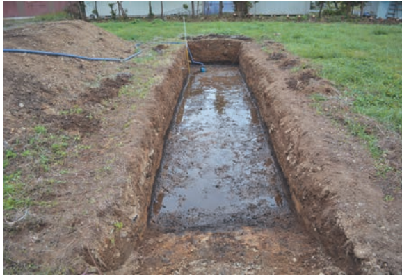
写真 33 2 T 調査状況
