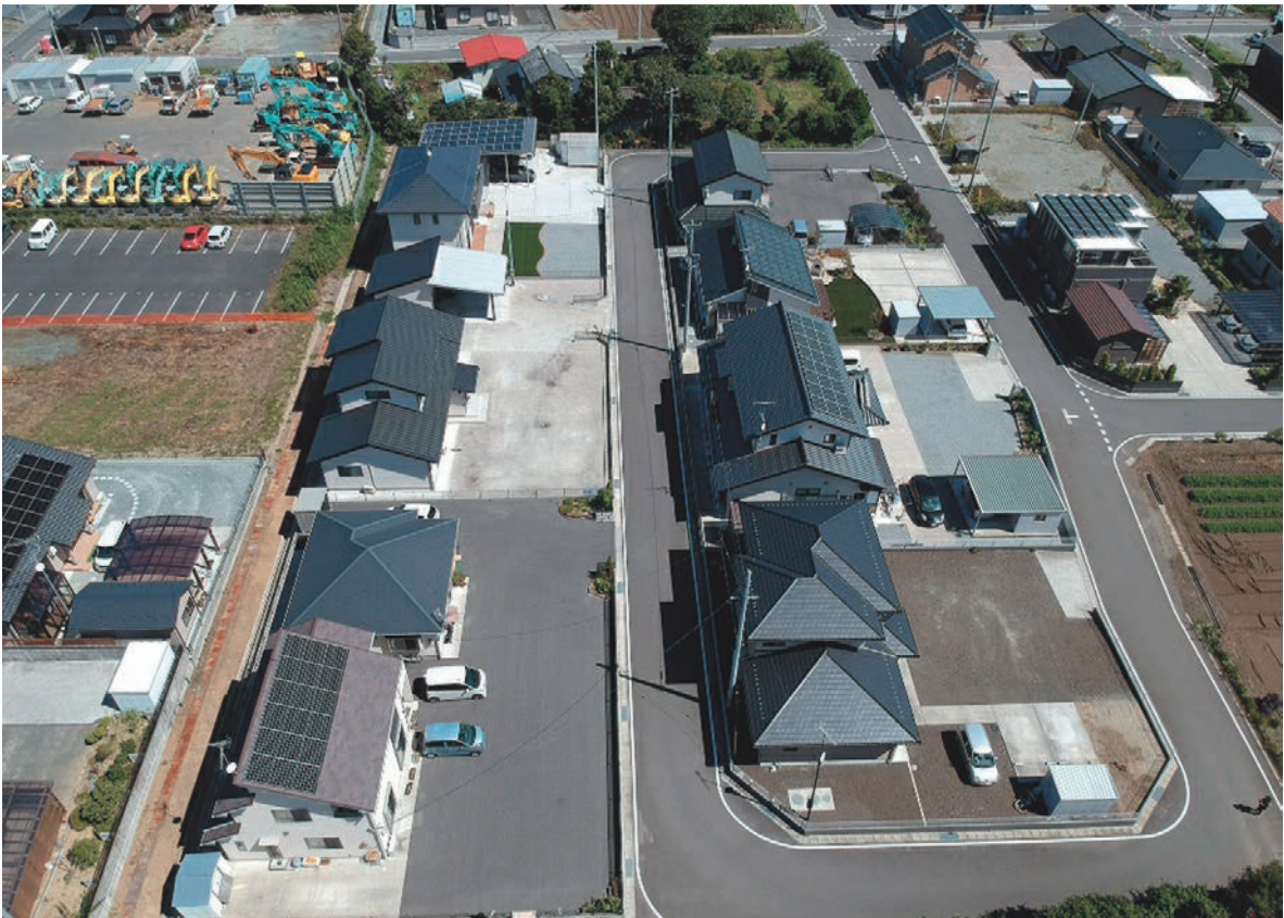
写真 55 B地区施工後近景
