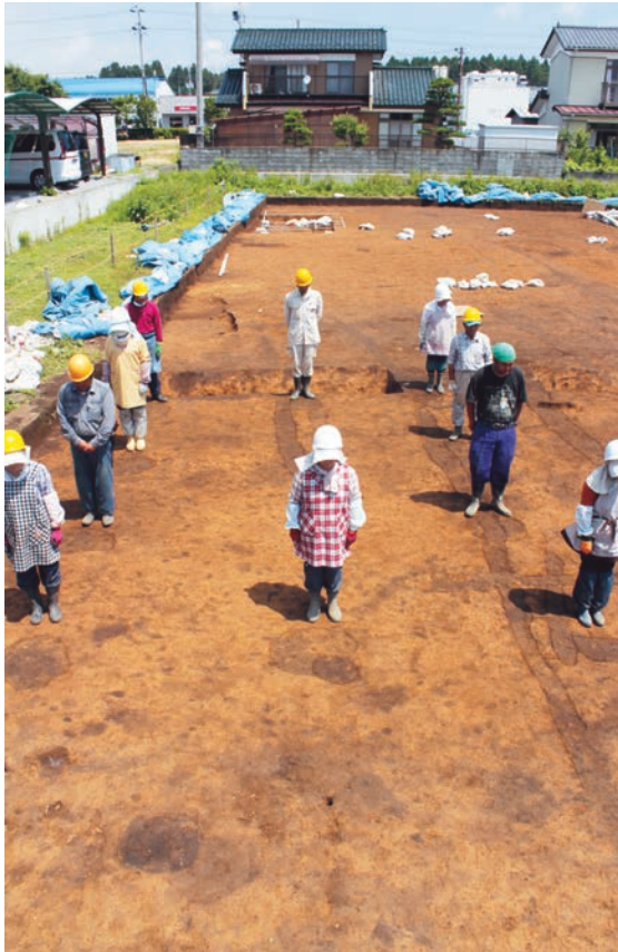
写真 144 20号掘立柱建物跡 柱位置
