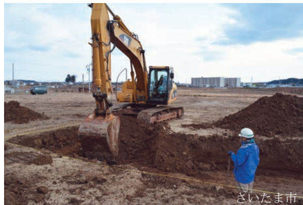
写真20 復興調査支援状況（8）
