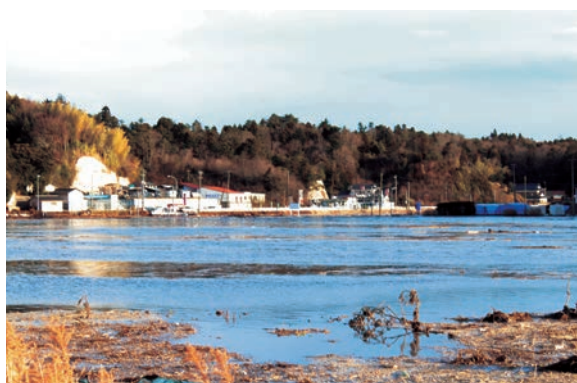
写真6 東日本大震災被害状況（6）
