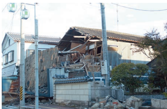
写真5 東日本大震災被害状況（5）
