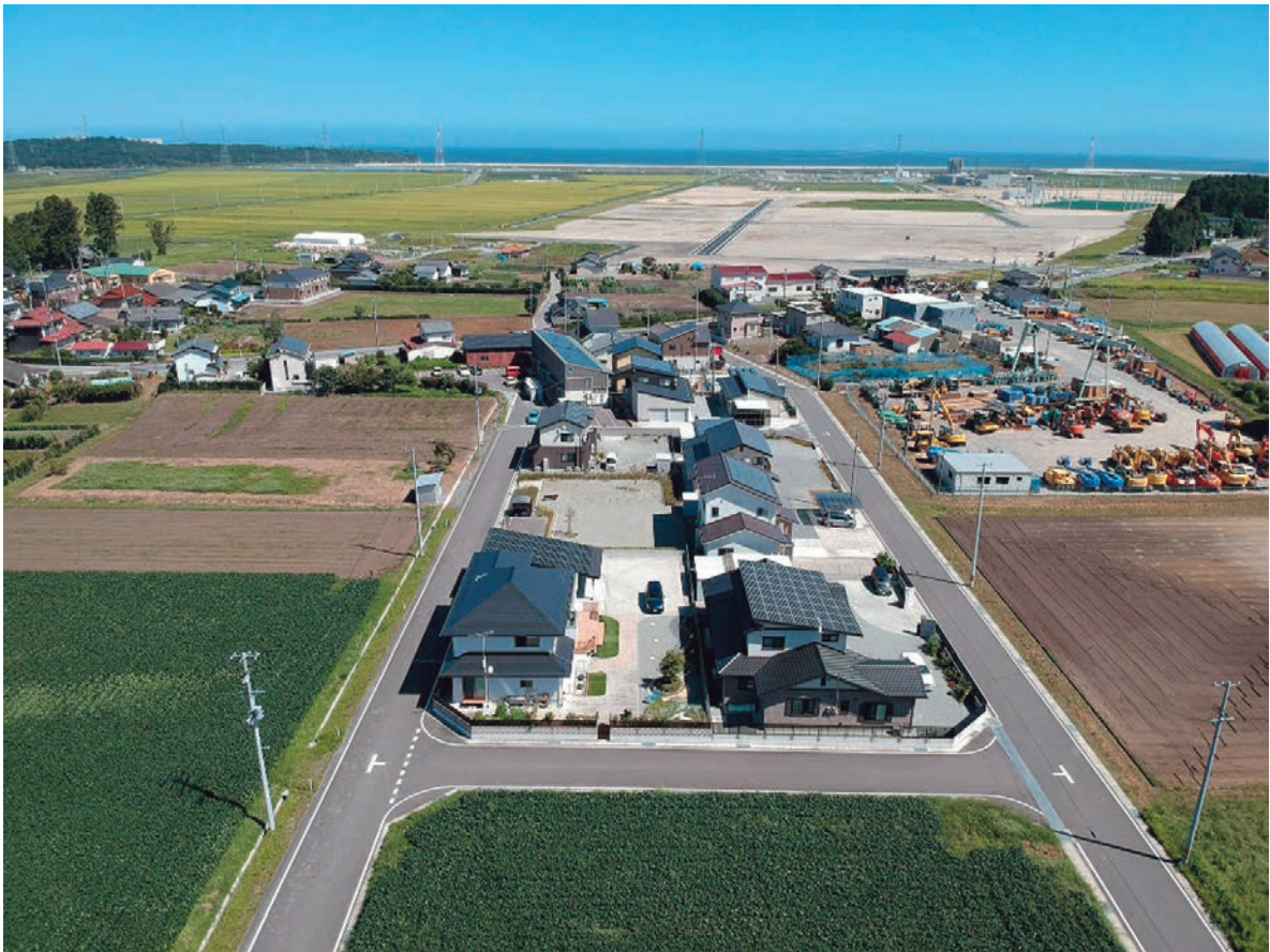
写真 53 A地区施工後近景
