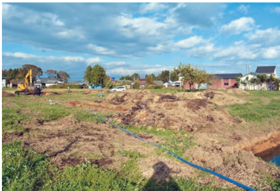
写真 25 重機掘削状況
