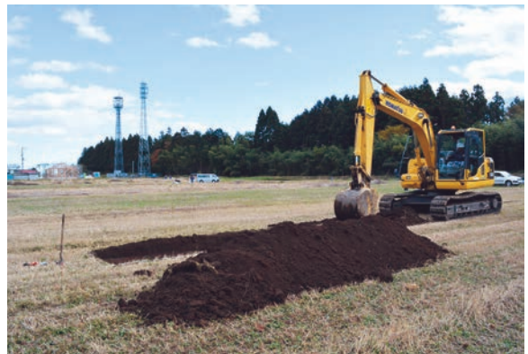
写真 26 重機掘削状況
