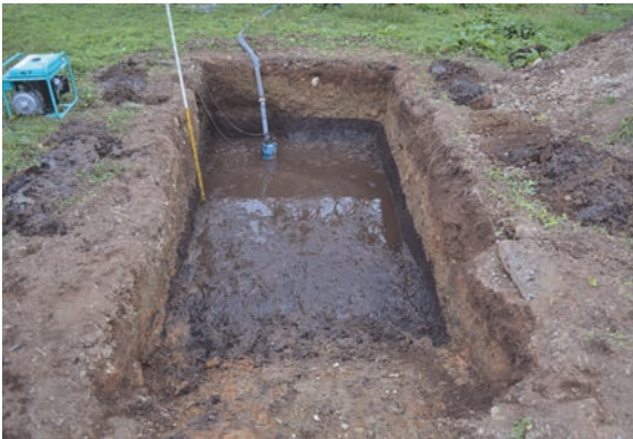
写真 29 3 T 調査状況
