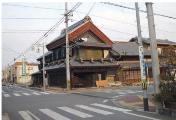
写真11 東日本大震災被害状況 (11)
