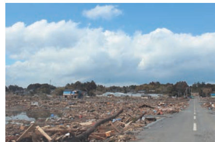
写真4 東日本大震災被害状況 (4)
