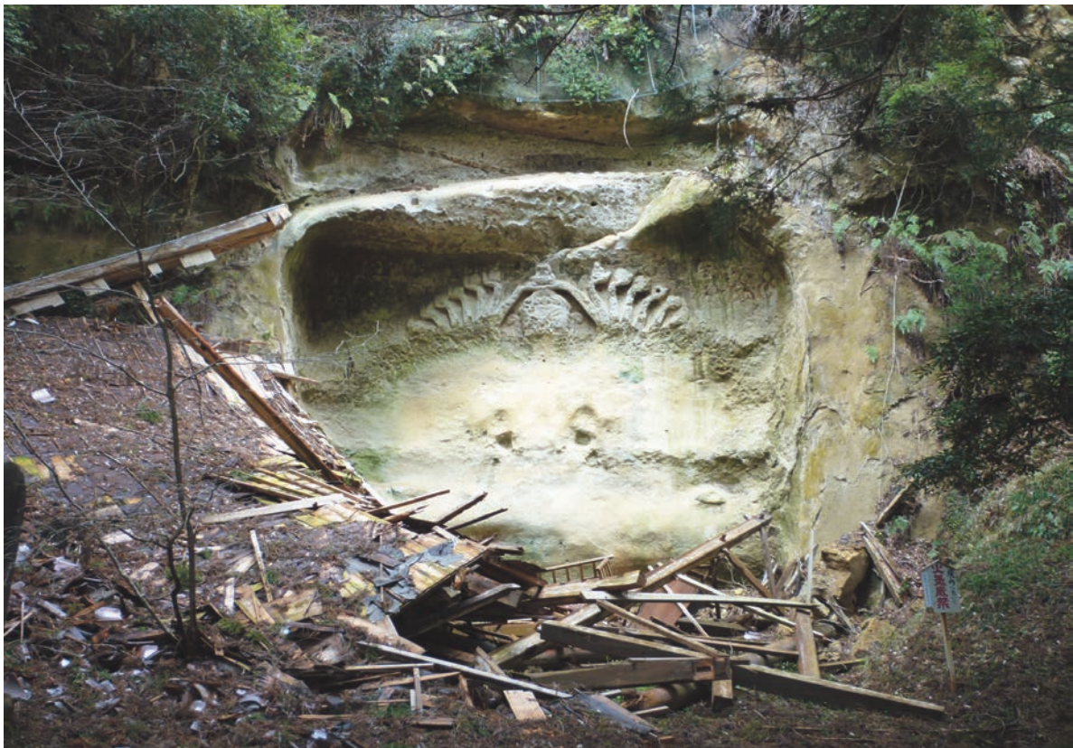
写真1 東日本大震災被災状況(1)
