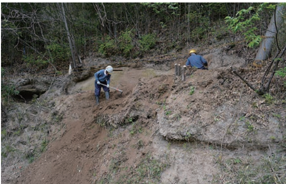
写真3 検出作業状況
