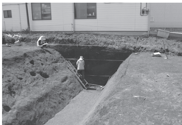
駒林遺跡第 35 地点本調査風景 2
