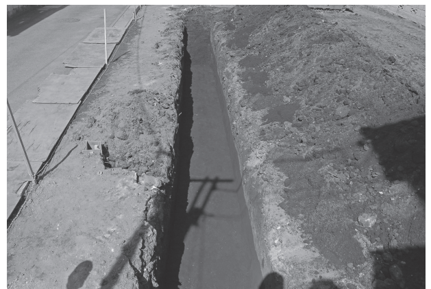
西ノ原遺跡第 165 地点トレンチ
