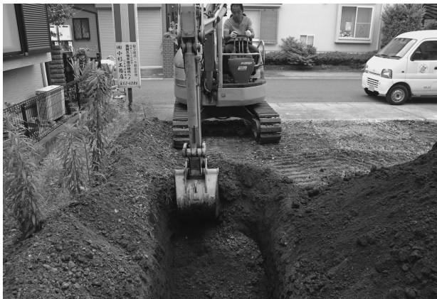
東久保遺跡第 72 地点調査風景
