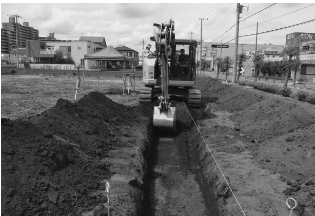
東中学校西遺跡第 36 地点調査風景
