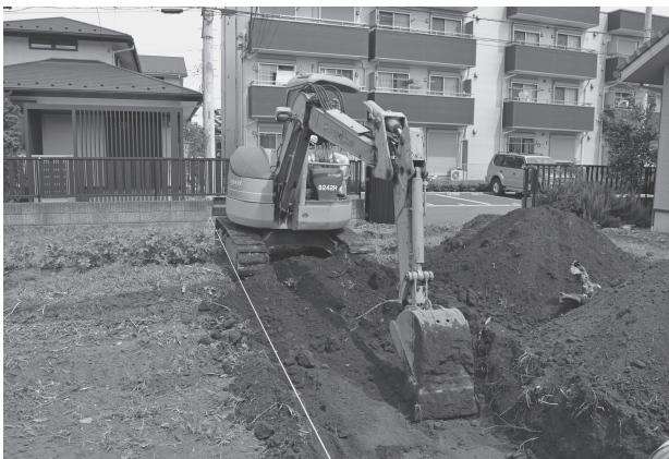
亀居遺跡第 75 地点調査風景
