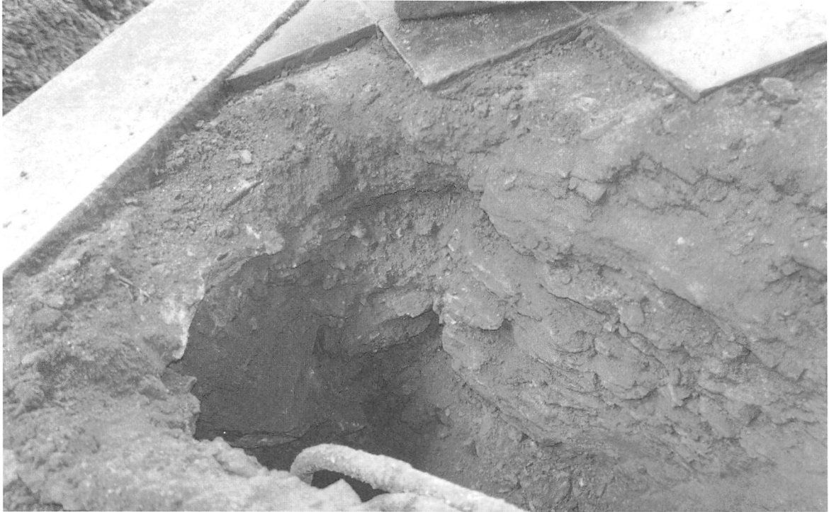
図70 五大堂基壇断面（北西から）
