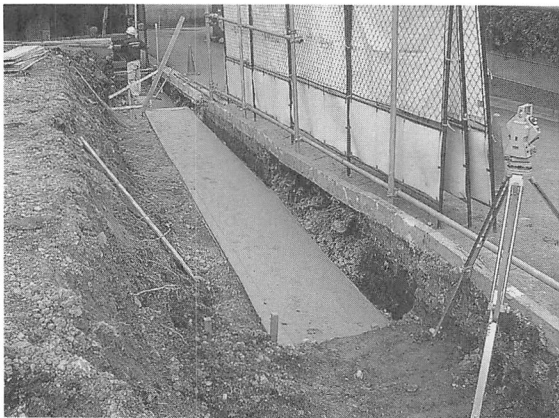
図29 ピット2（南東から）
