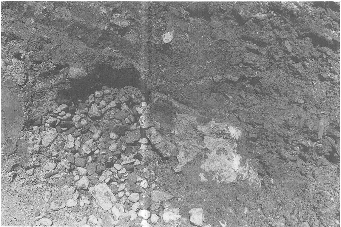
図95 No.4 石垣断面 (南から)
