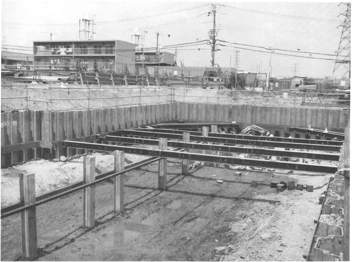
1 No.2・3地点 全景 (南東から)
