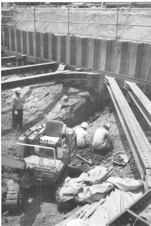
2 No.2地点 全景 (北東から)
