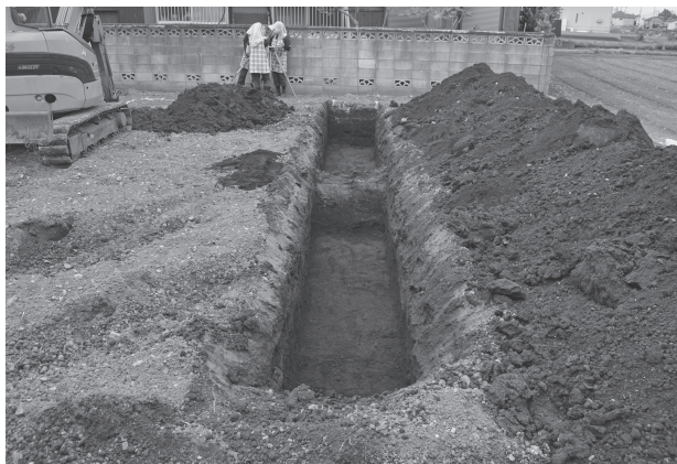
川崎遺跡第 43 地点トレンチ 1
