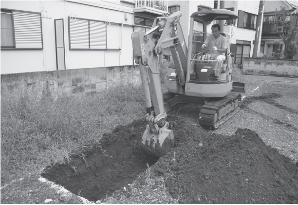
北野遺跡第 31 地点調査風景
