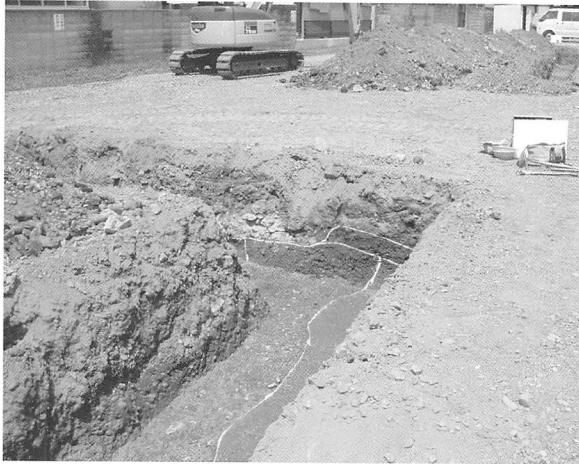
写真 11 2T・3T 溝 1 検出状況 (南東から)
