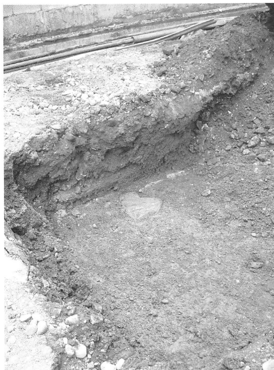
写真3 1Tr. 上層礎石検出状況(北東から)
