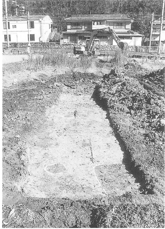
写真17 11トレンチ全景 (南から)
