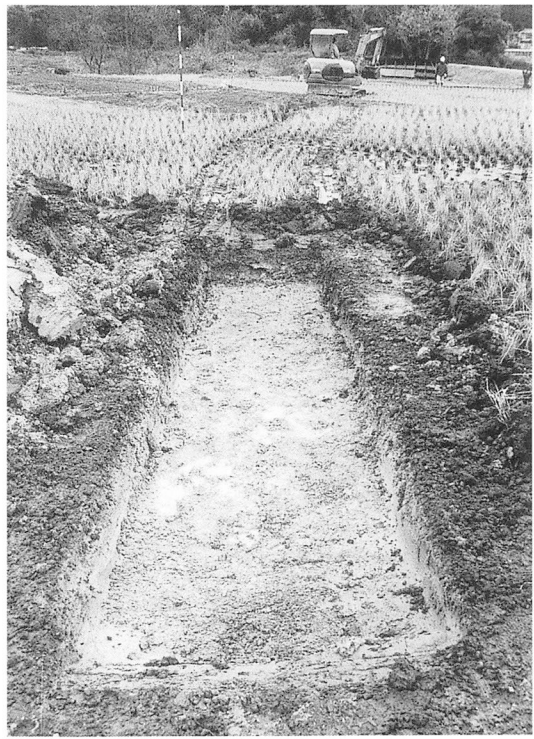
写真19 23トレンチ全景 (南から)
