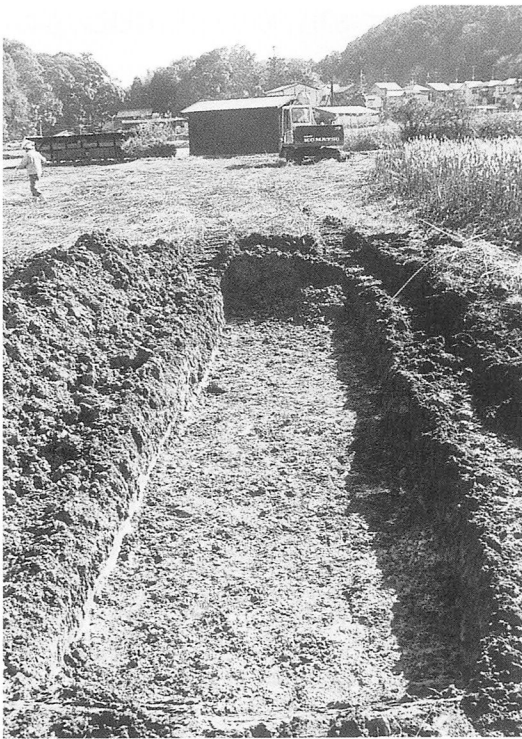
写真18 16トレンチ全景 (北から)
