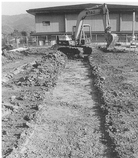
写真13 1 トレンチ全景 (西から)
