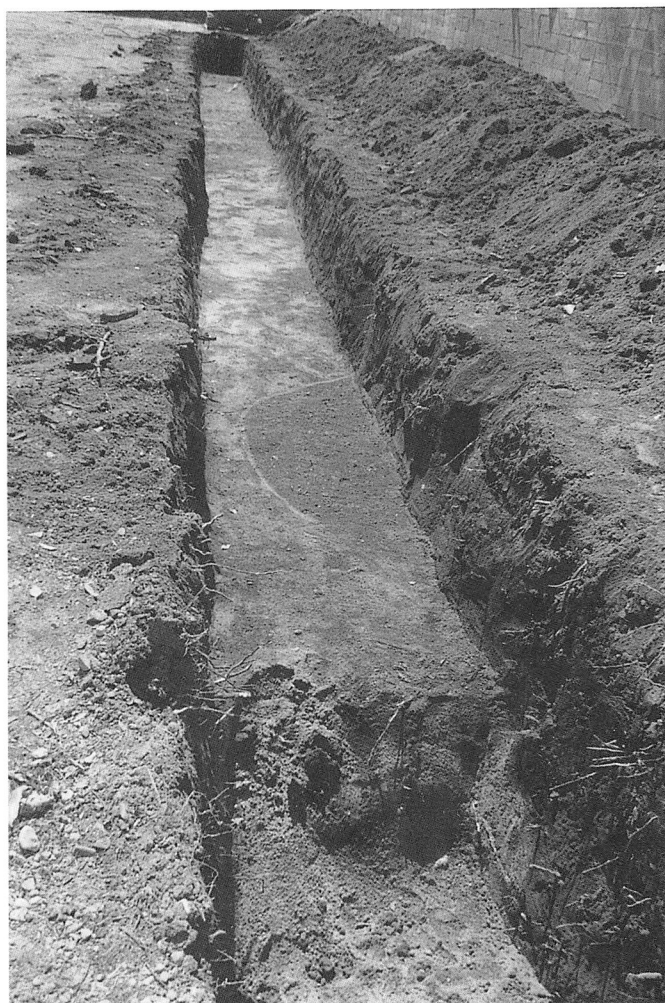
写真9 1トレンチ全景(北から)
