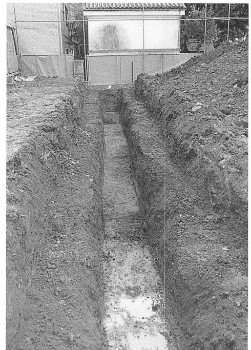
写真5 2トレンチ完掘状況 (東から)
