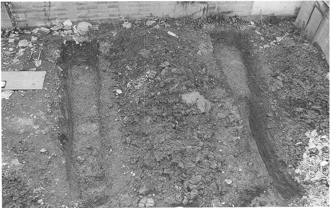
写真8 調査地全景 (西から)
