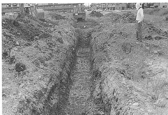
写真15 5トレンチ全景 (東から)
