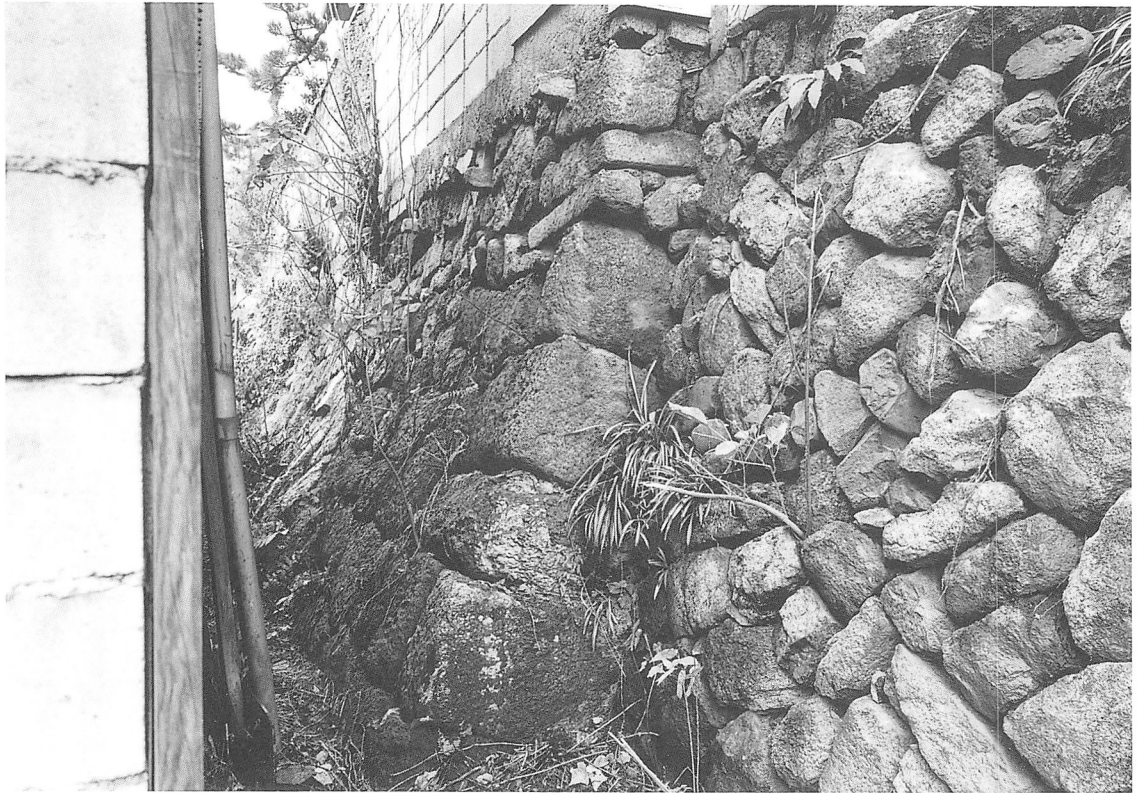
写真1 現存石垣（東から）
