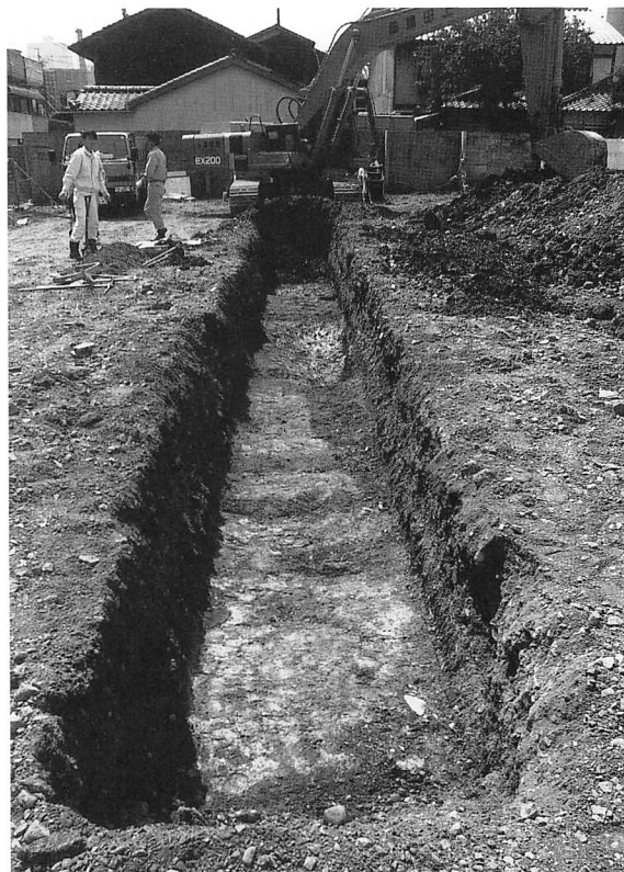
写真5 トレンチ写真(北から)
