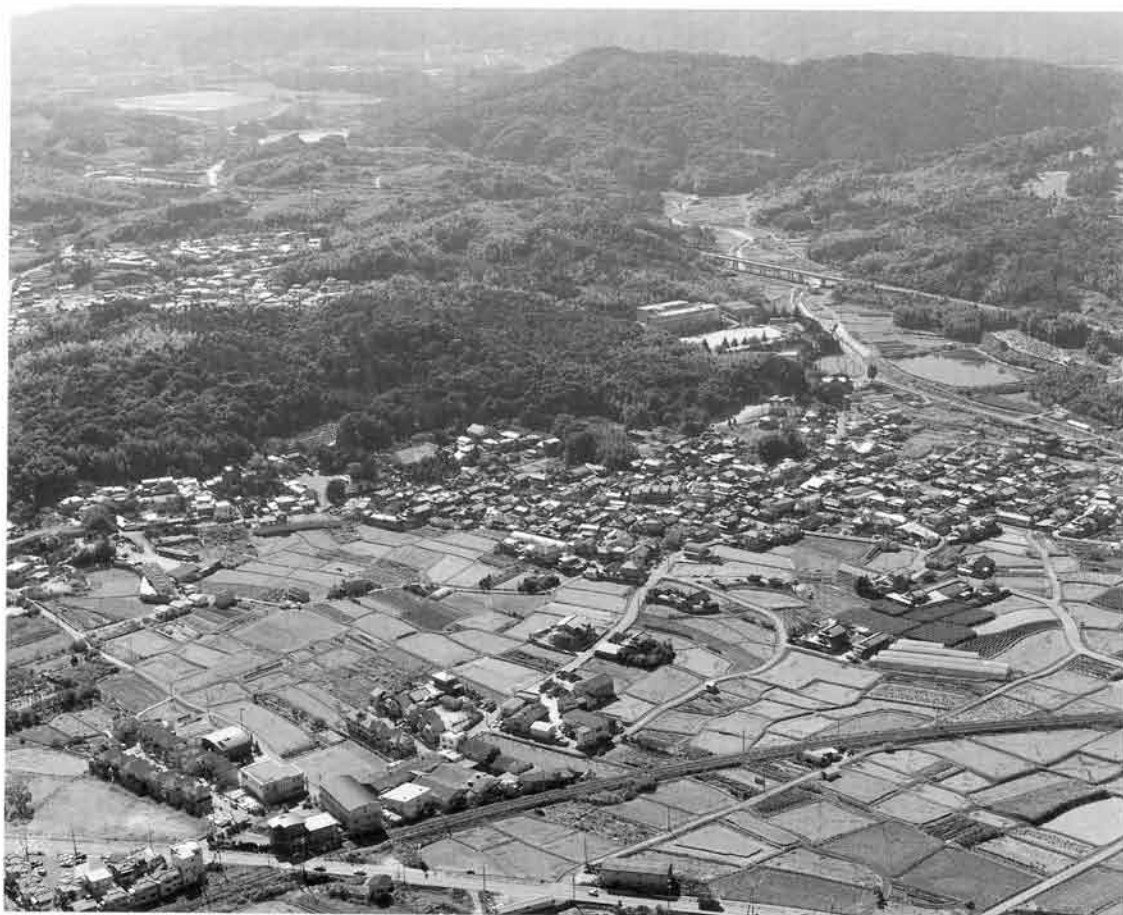
第2図 薪遺跡遠景（北東から）
