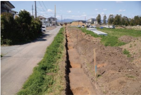
写真図版13 南側側溝、下水管設置部分全景(東から)
