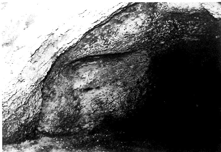
2. 横穴西壁の状態(開口部より)
