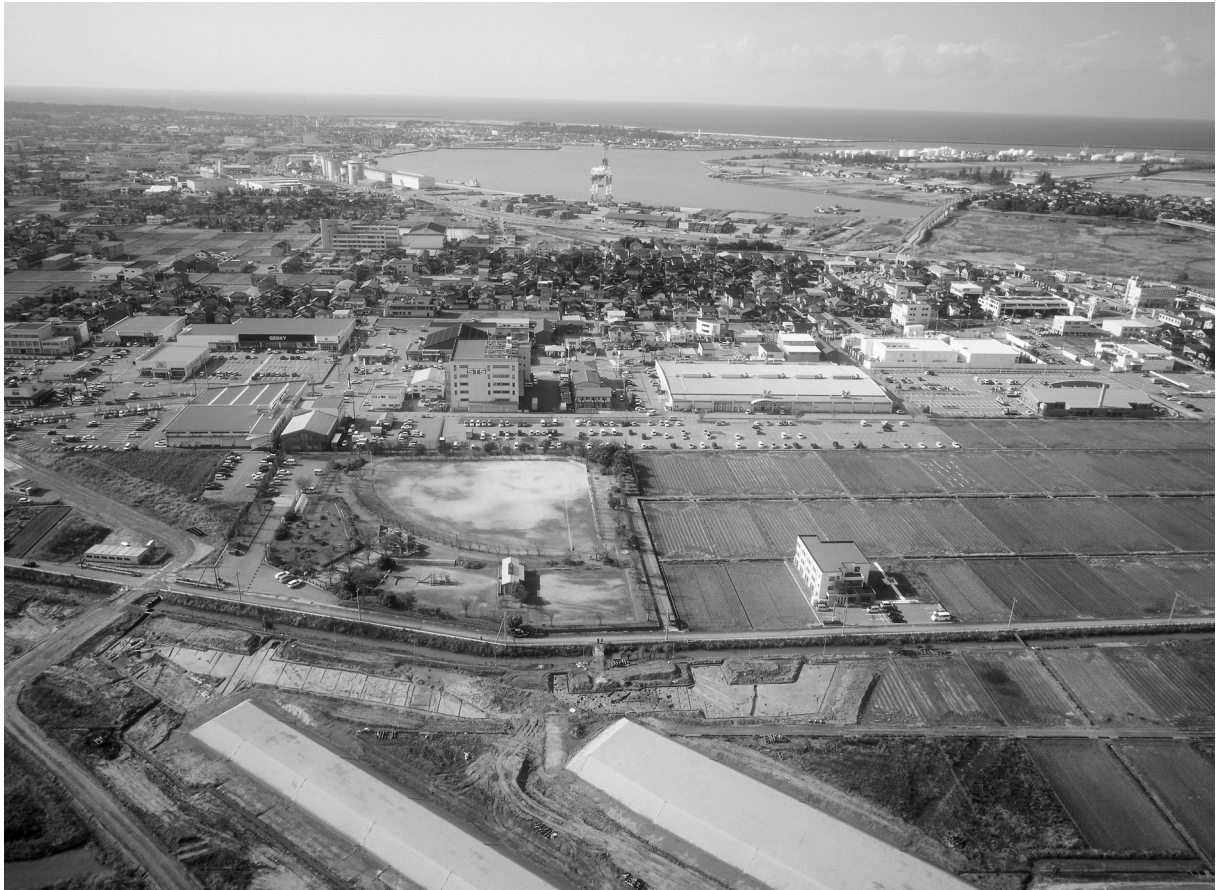
08 年度 仮水中区・仮水北区（東から撮影）
