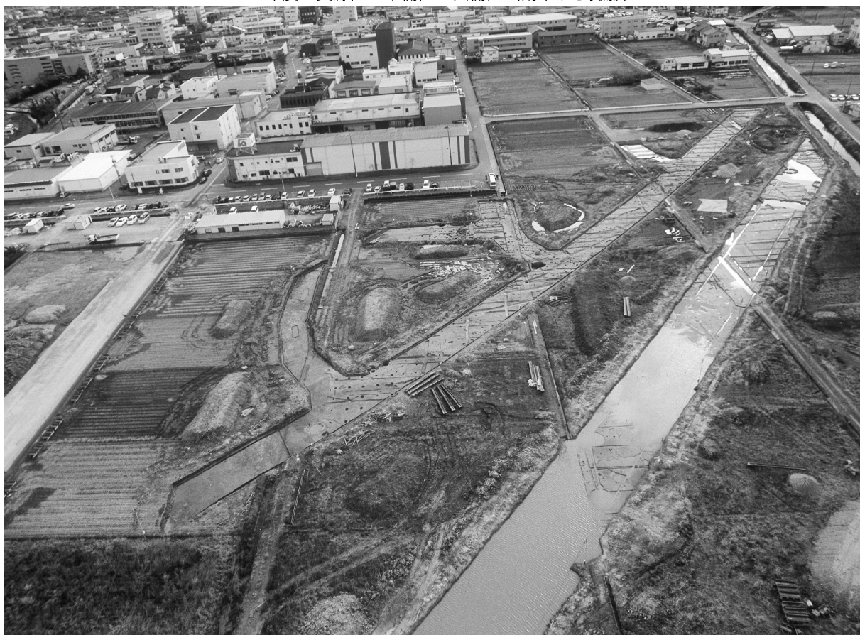
07 年度 支線区・枝区（北から撮影）
