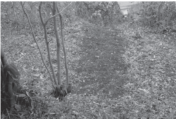
埋め戻し状況 (南から)
