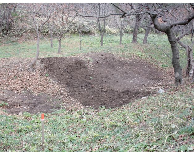
埋め戻し状況 (南西から)
