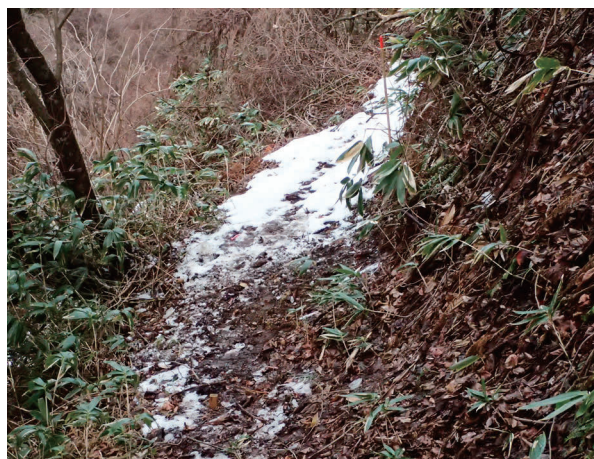
埋め戻し状況 (南から)
