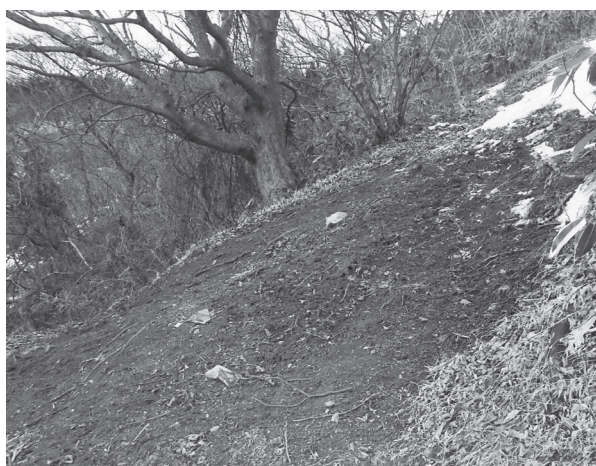
埋め戻し状況 (北から)
