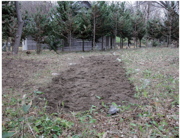
埋め戻し状況 (西から)
