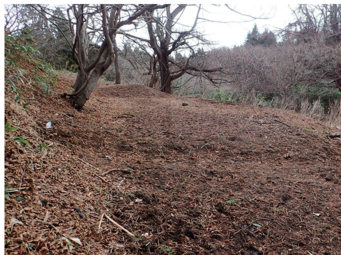
埋め戻し状況（西から）
