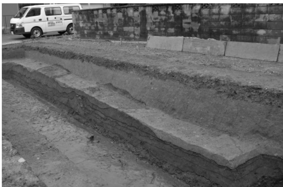
南壁断面（北西より）
