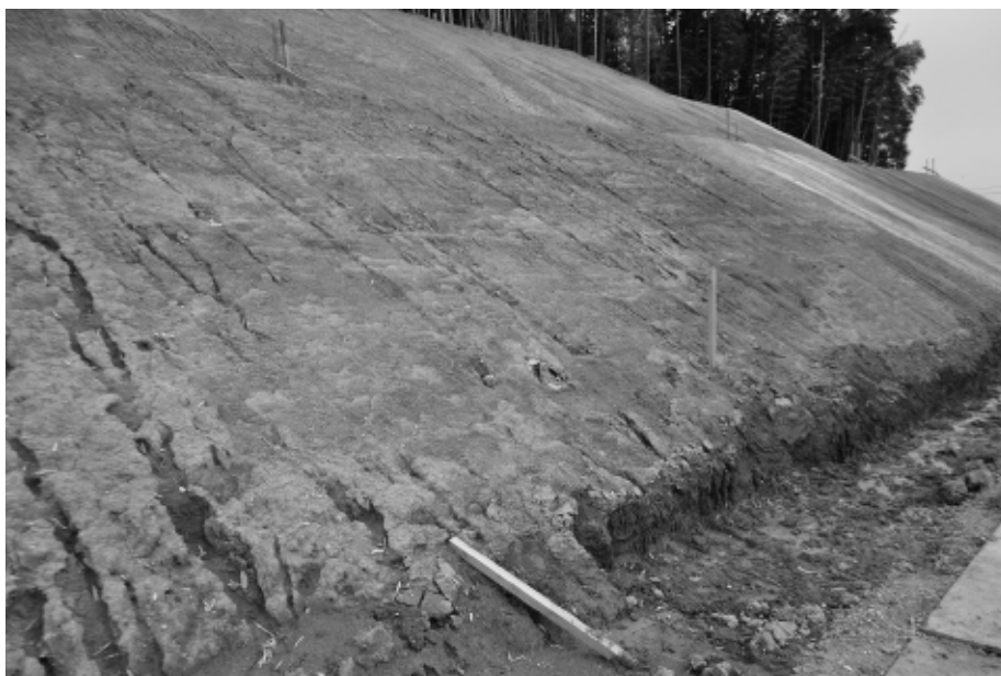
発見時の状況① (南東より)
