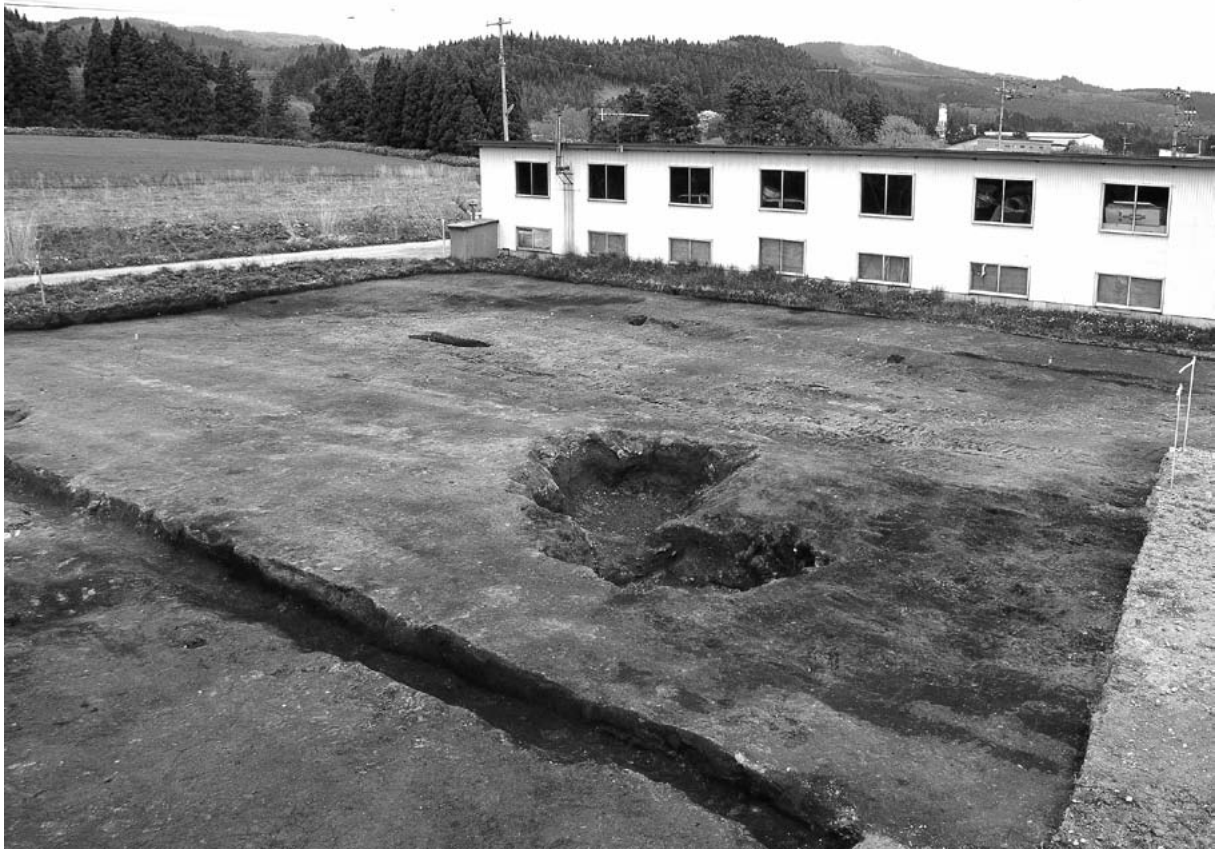
1 クリーニング作業後盛土遺構確認状況 S→N
