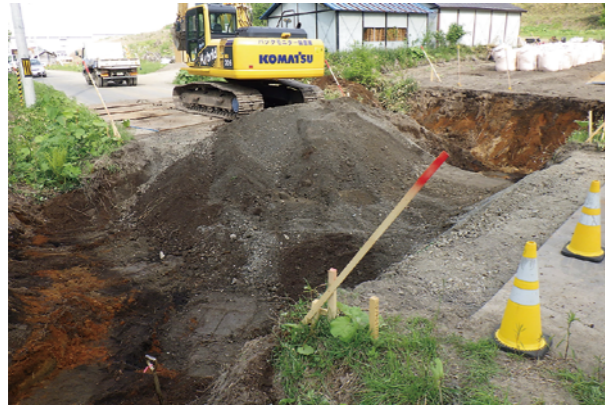
1. 立会地区工事状況
