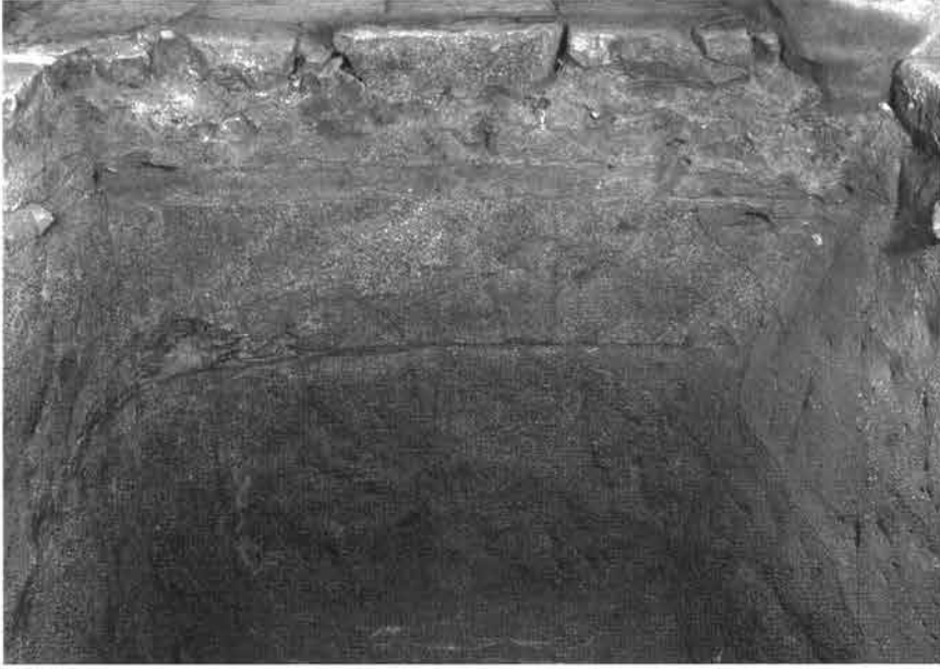
防空壕北壁（南より）
