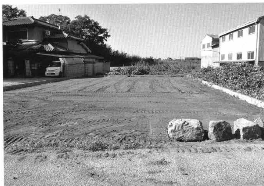
埋戻後の状況（南より）
