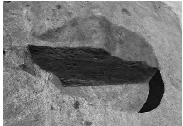
S K29 断面 (西から)
