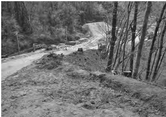
5区南側斜面 現況 (北から)
