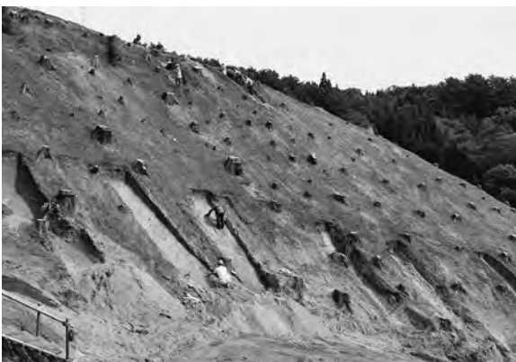
3区作業風景（南から）
