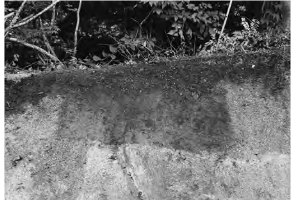
S K28 断面 (東から)
