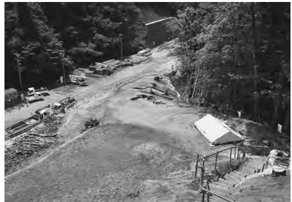
5区南側斜面 平面 (北から)
