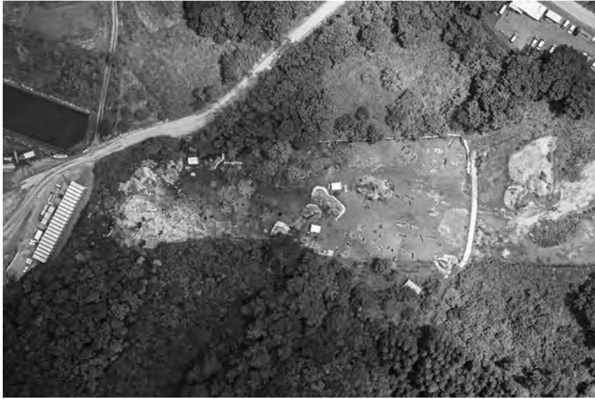
C区～F区全景(平成27年度) 上が南東
