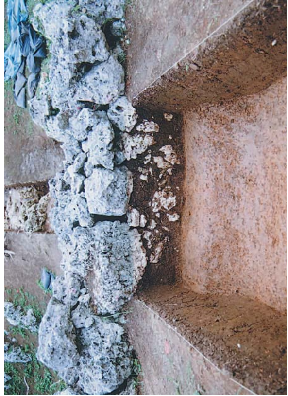
図版107. 堀切トレンチ4石積み下部 南セクション
