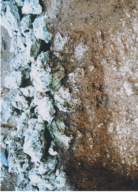
図版102. 堀切トレンチ3石積み下部 南セクション
