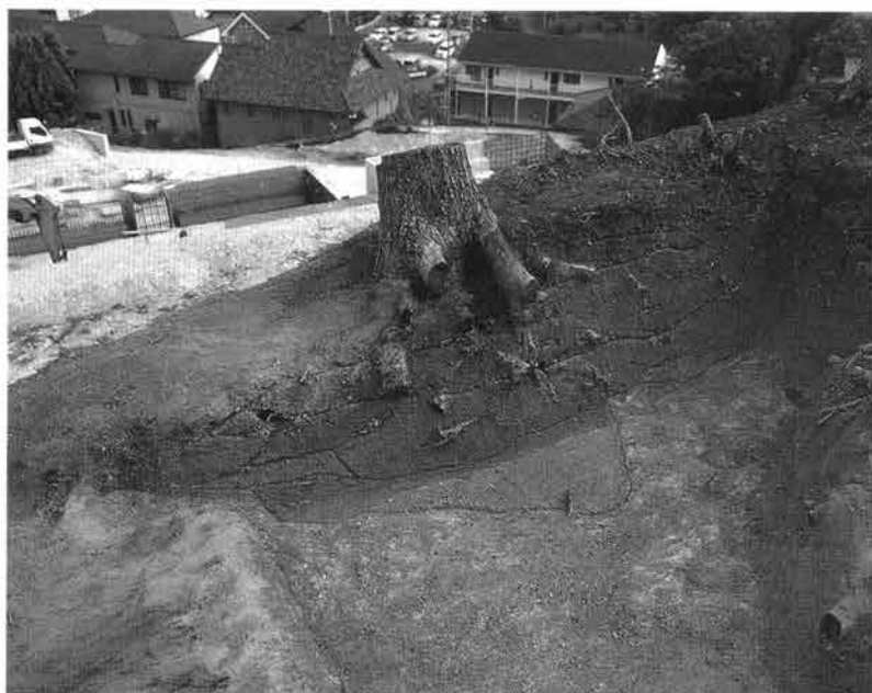
流土層断面（北より）
