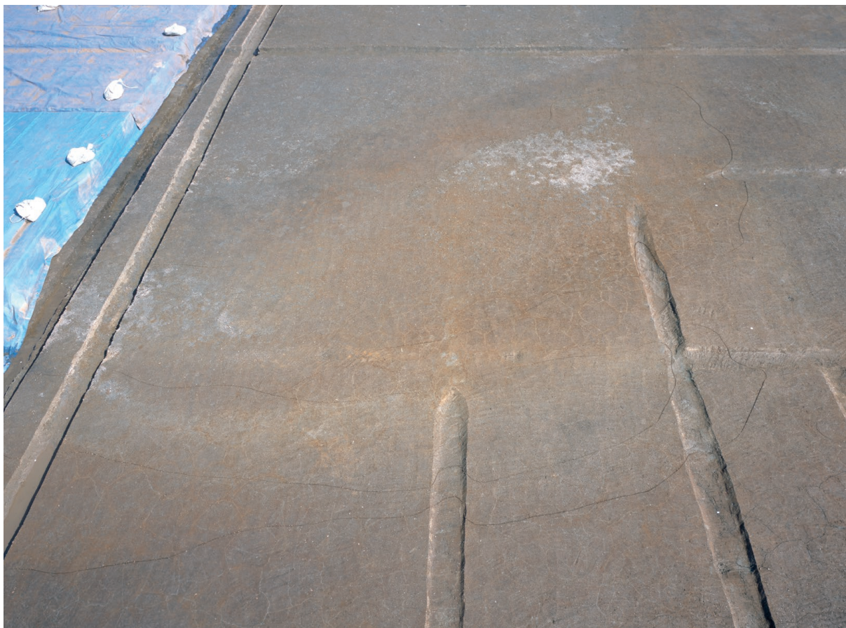
1区 10219・10220SD 検出状況（南から。溝東端部付近）
