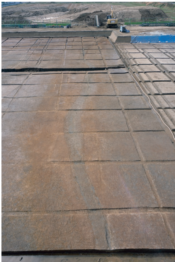
1区 10146SD 検出状況 (北から)
