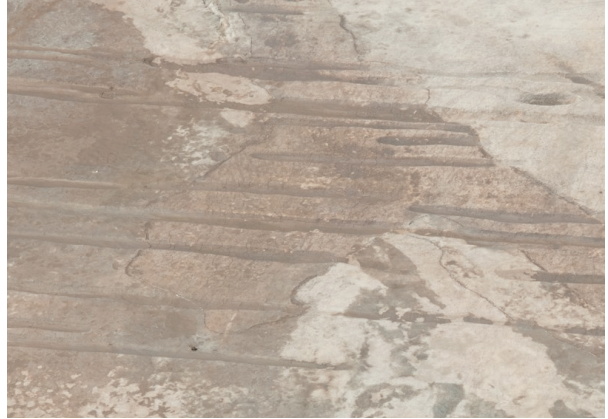
2区 20417SX 検出状況 (東北東から)
