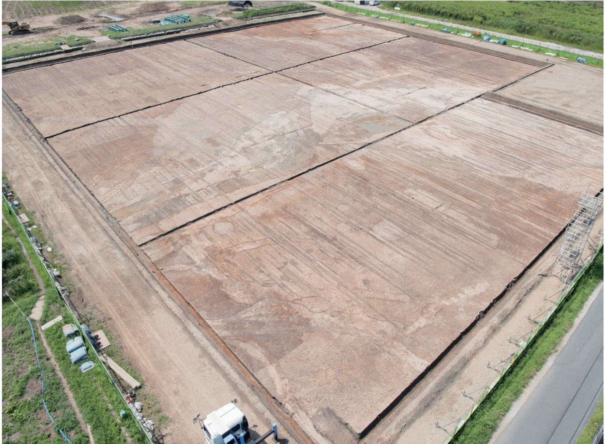
2区 上層遺構完掘状況、中層遺構検出状況（北東から）
