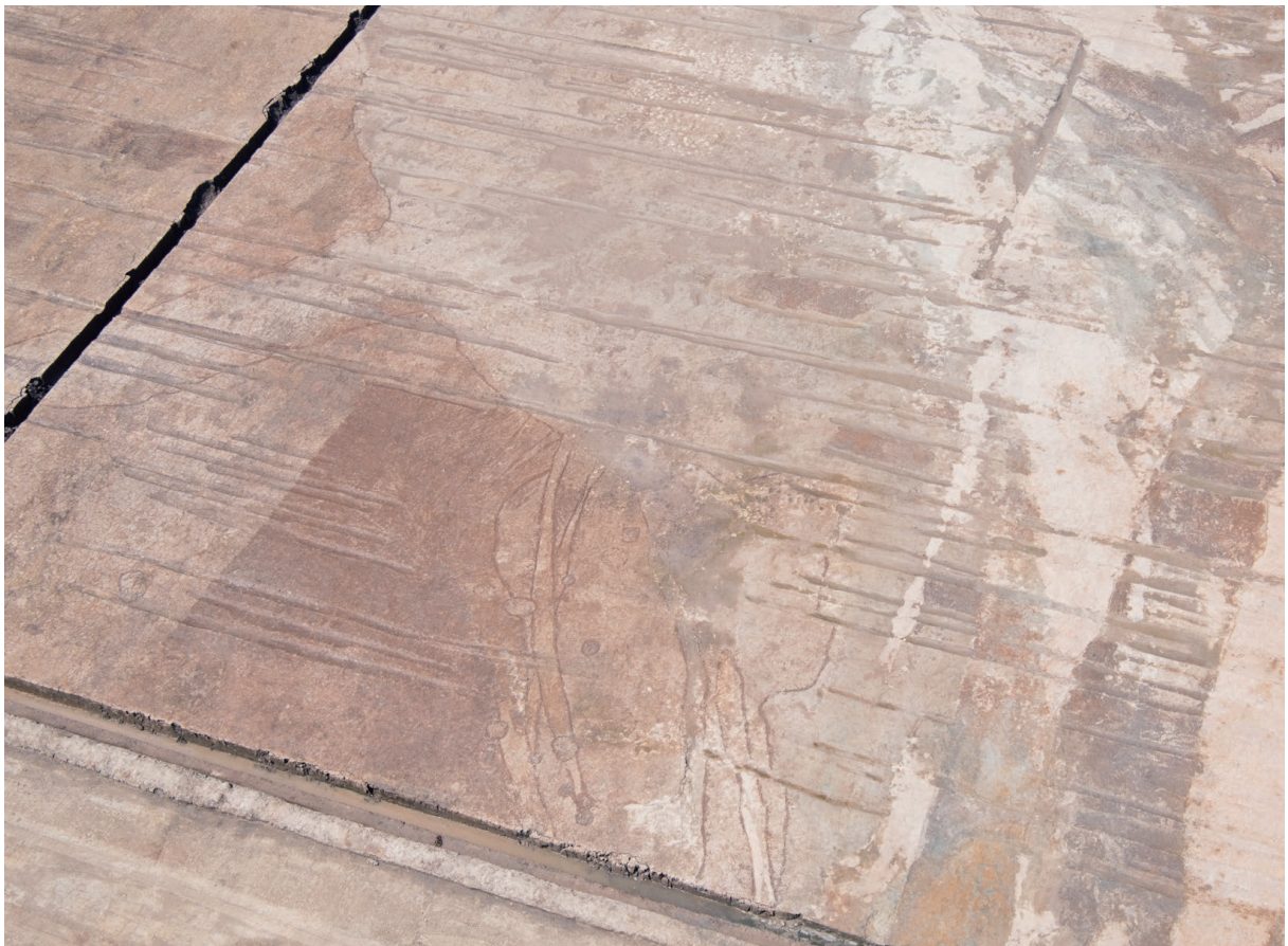
2区 河道南岸 中層遺構検出状況（東北東から）
