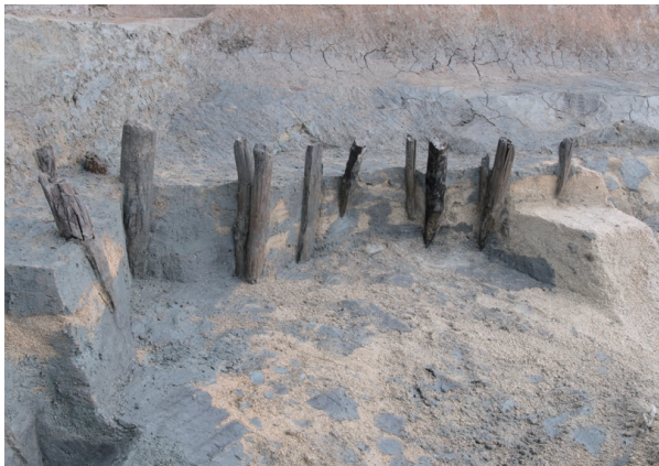
2区 河道 杭列③北半出土状況 (南西から)
