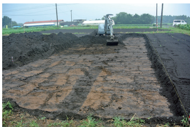
6AHE-D区西トレンチ表土除去作業 (北から)
