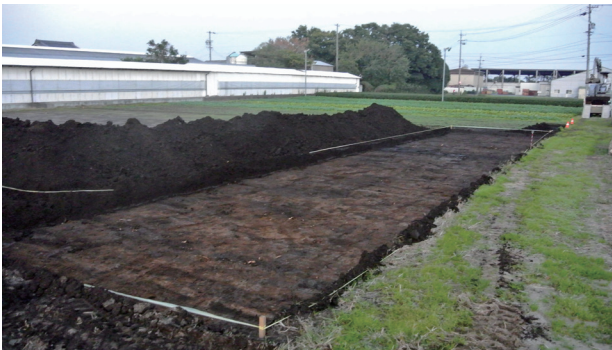
6AIB-D 区東西トレンチ表土除去 (南西から)
