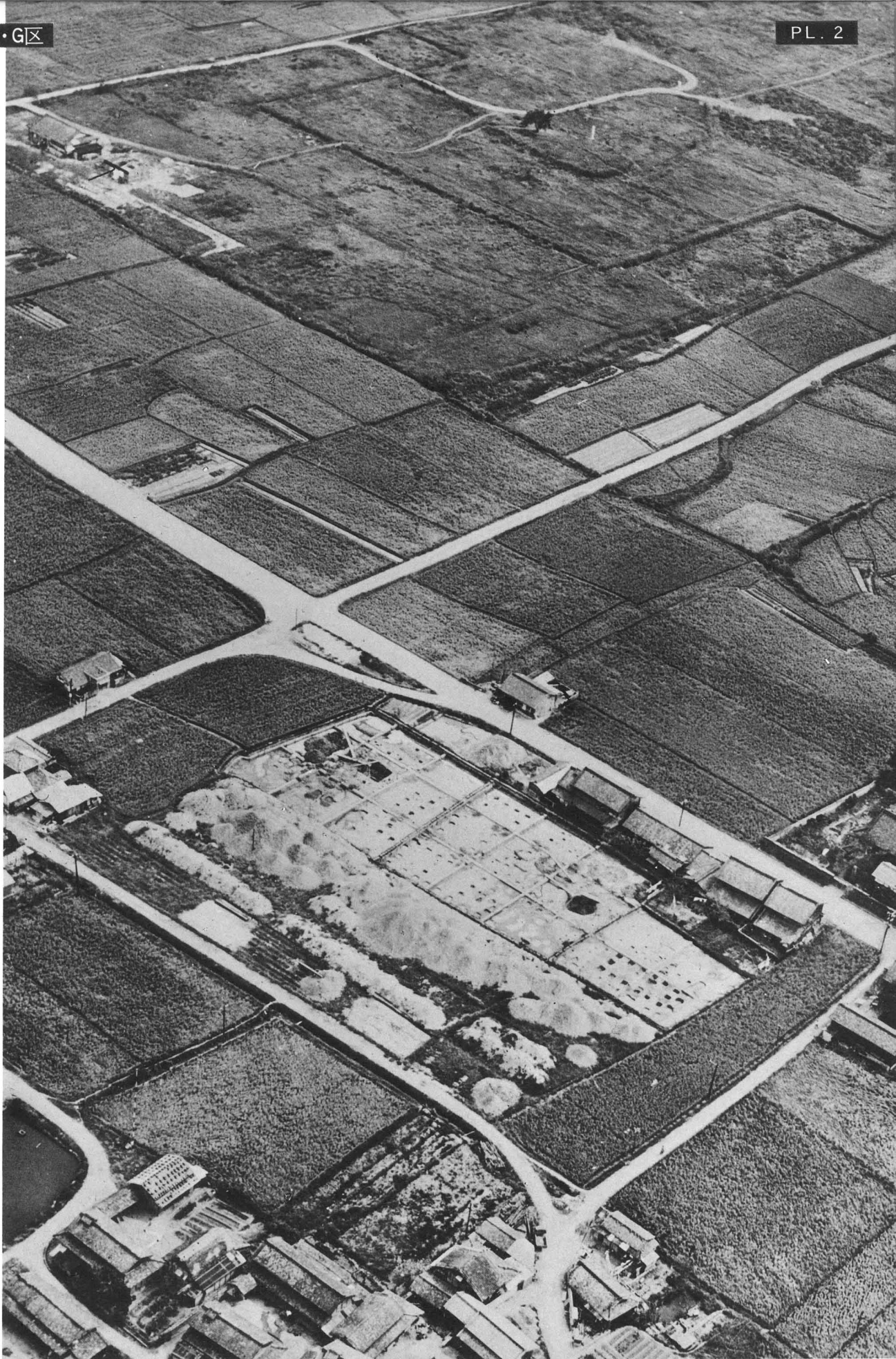
6AB0-D・F・G区と第2次朝堂院・内裏地域 西北から
