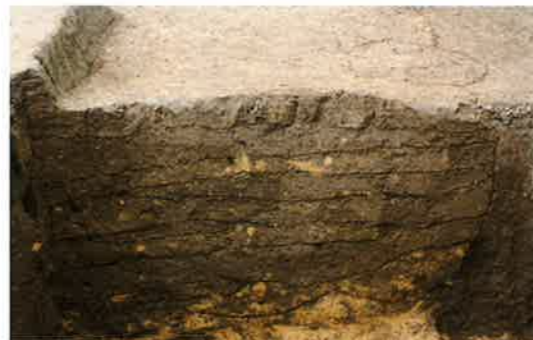
建物の基礎のようす。何回にも分けてかたくしめていることがわかります。
