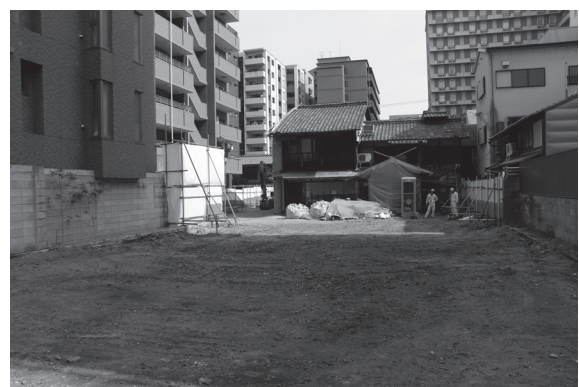
図22 第2次調査調査前全景（南から）
