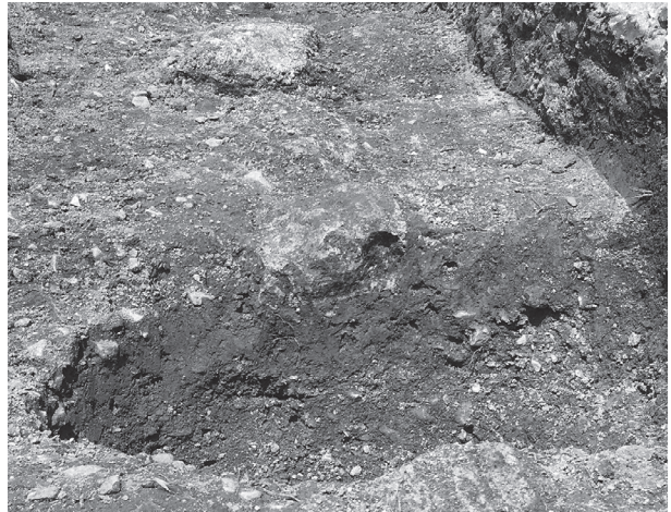
図57 延石据え付け状況(南から)
