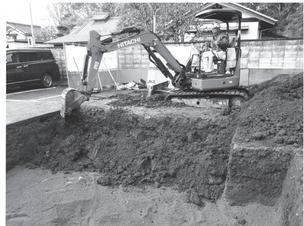
図5 埋め戻し風景（北東から）
