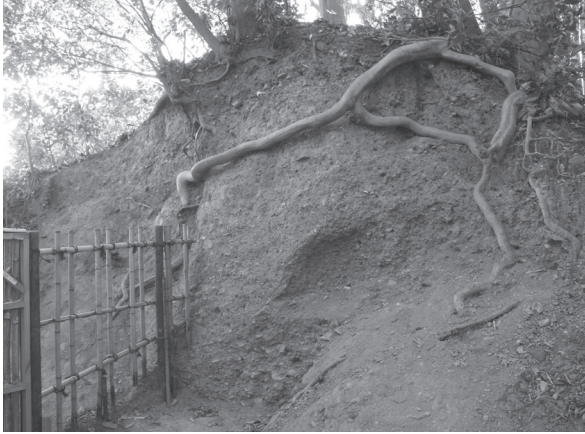
1 現存土塁切り通し西面 (北東から)
