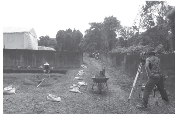
図2 調査風景2（北東から）
