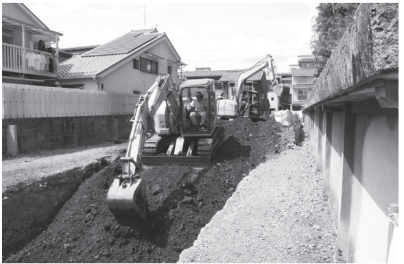
図5 埋め戻し風景（南東から）
