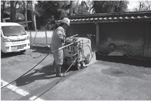
図2 アスファルトカット風景（南西から）
