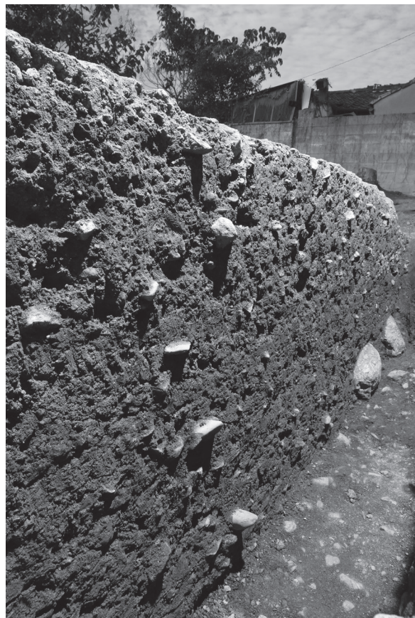
4 第7調査区地業38西壁断面（南東から）
