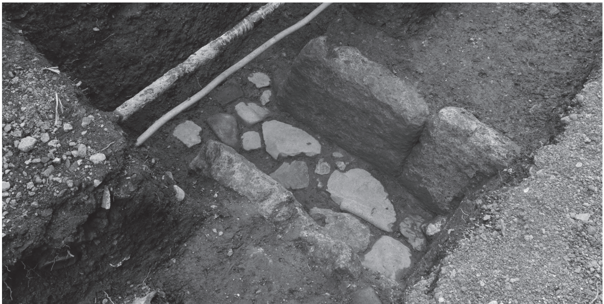
2 2区石組溝検出状況（北東から）
