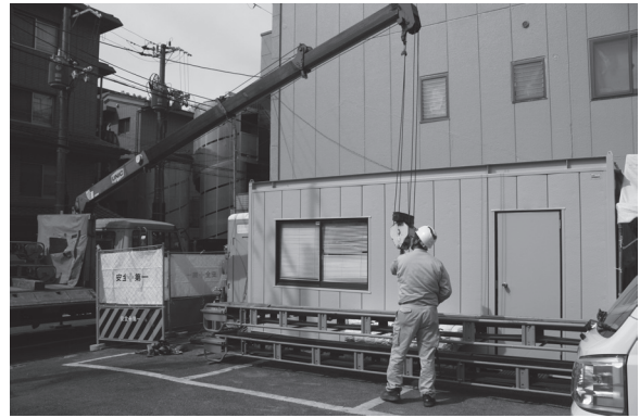
図3 機材搬入風景（北東から）
