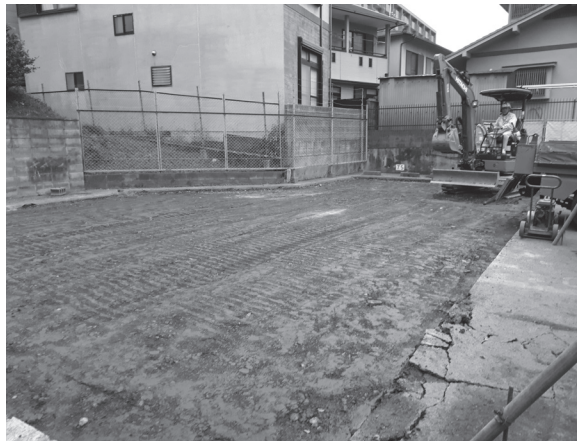
図6 埋め戻し風景（南西から）
