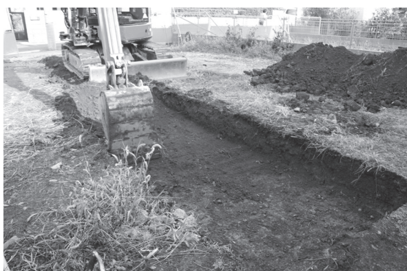
図2 機械掘削作業状況(第6次)
