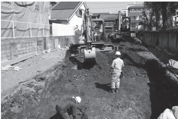
図4 重機掘削風景（南から）
