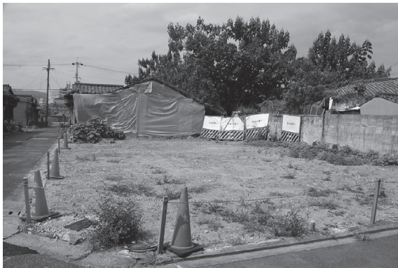
図3 第7調査区調査前全景(東から)
