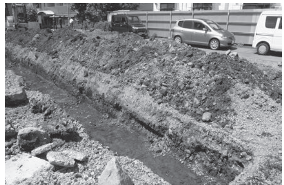
第19次調査 全景
