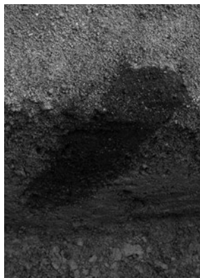
SP-1 土層断面(南東から)
