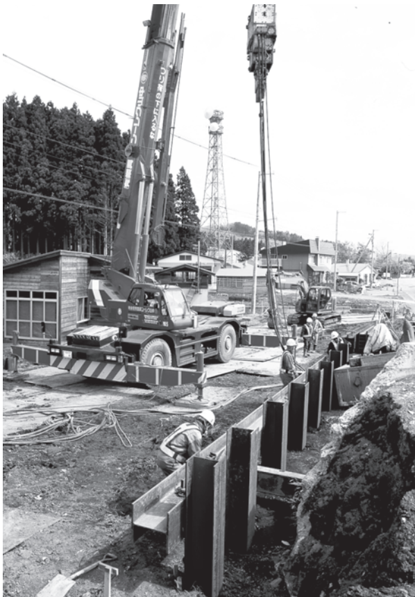
H鋼打設作業状況（南→）
