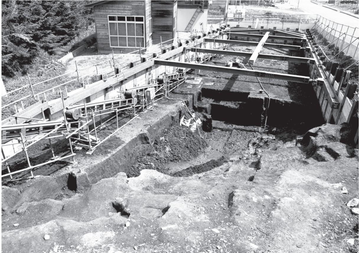
ベルトコンベア撤去前完掘状況（南→）
