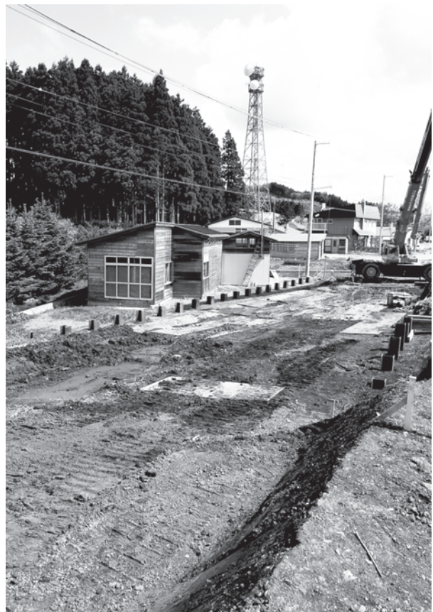
H鋼打設作業終了状況（南→）
