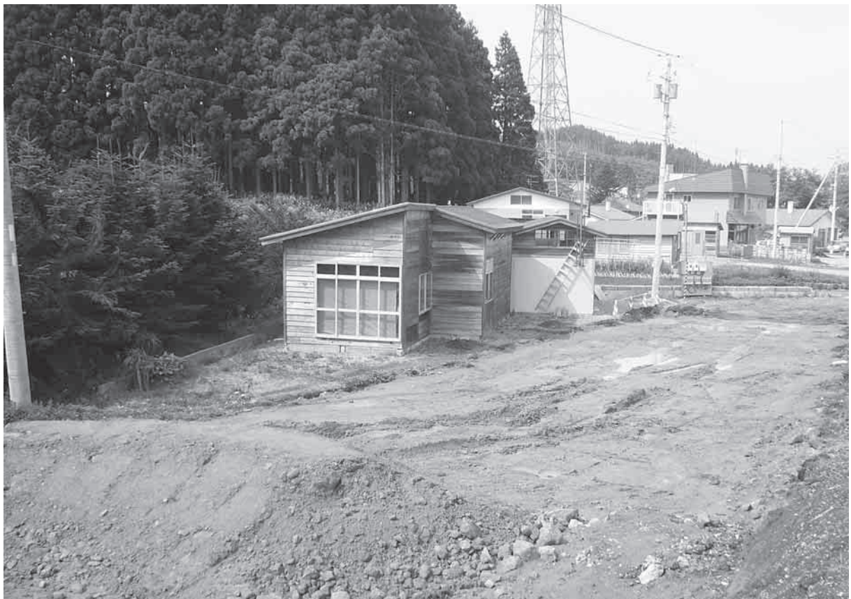
矢板撤去後埋戻し状況（南→）
