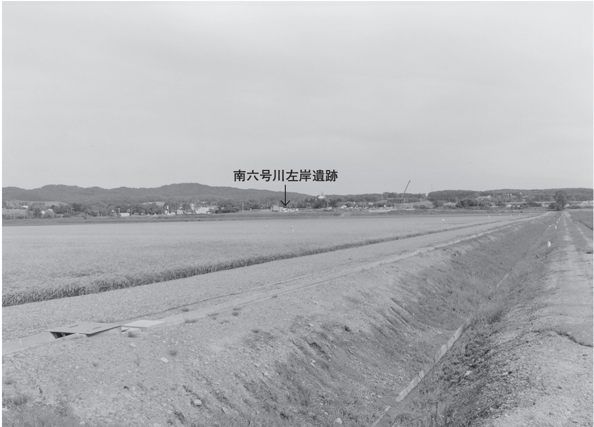
1 遺跡遠景（北西から）
