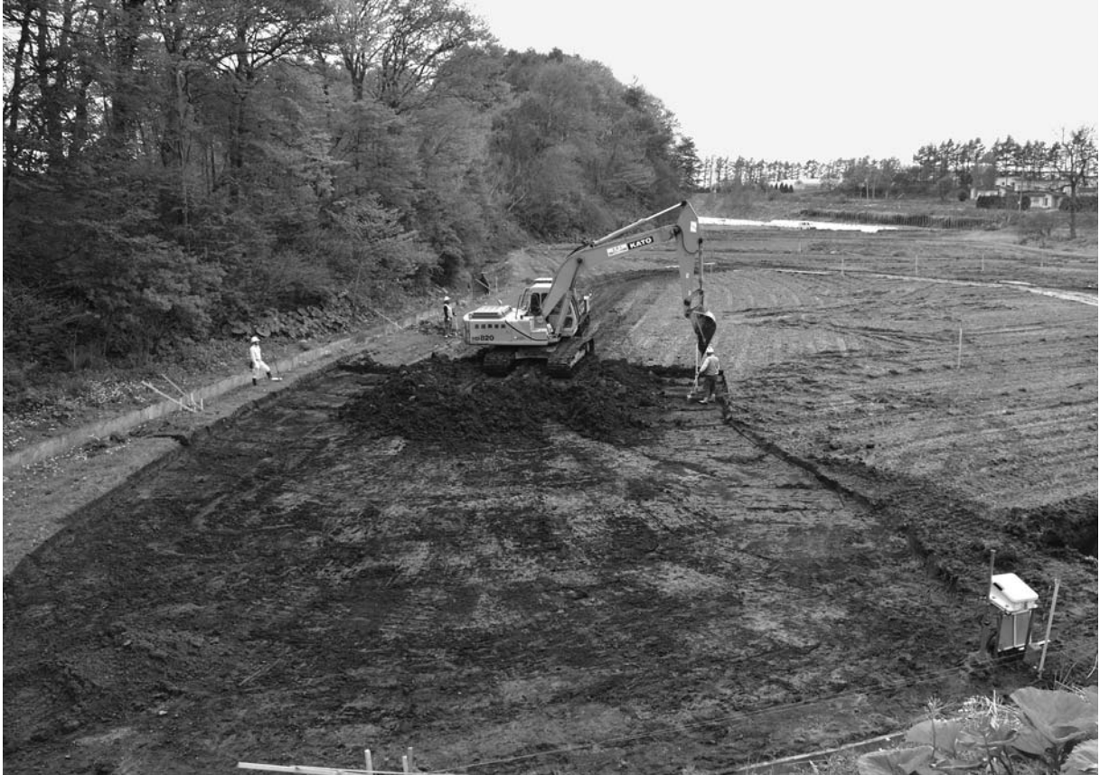
1 表土除去作業
