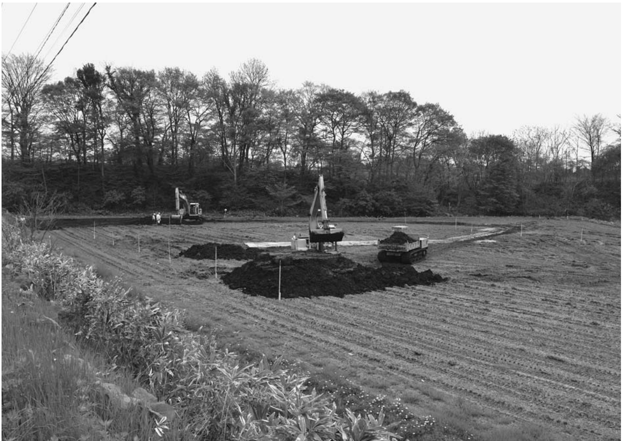
2 表土除去作業
