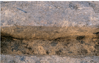
HF1 土層断面 (南から)
