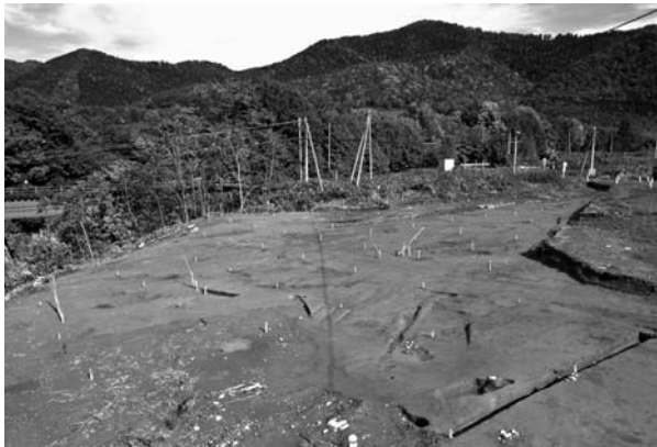
5 北側調査終了 (南から)
