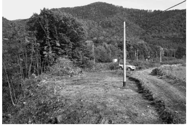
2 表土除去後 (南から)
