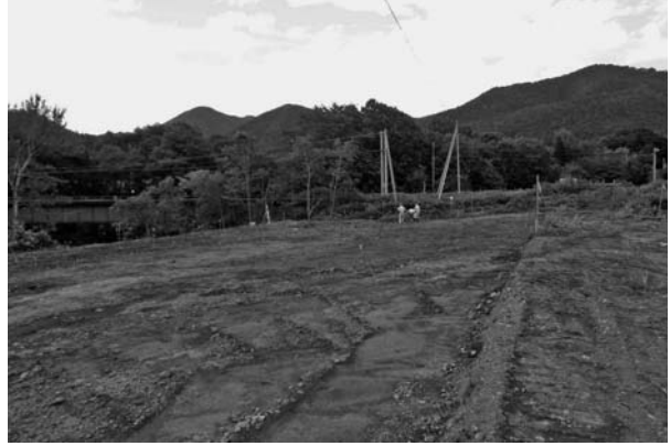
2 表土除去後（南から）
