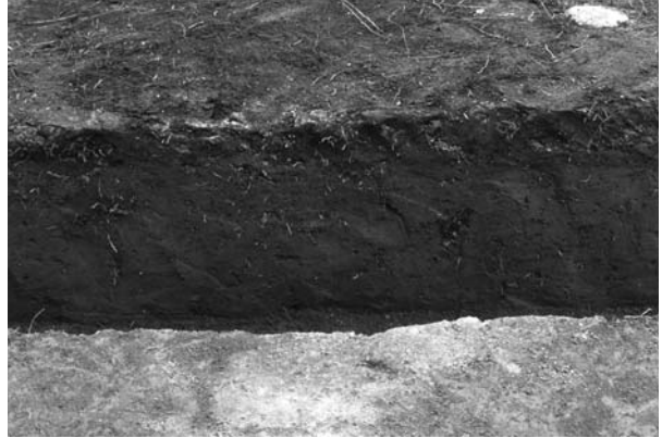
2 S2区北壁断面 (南東から)
