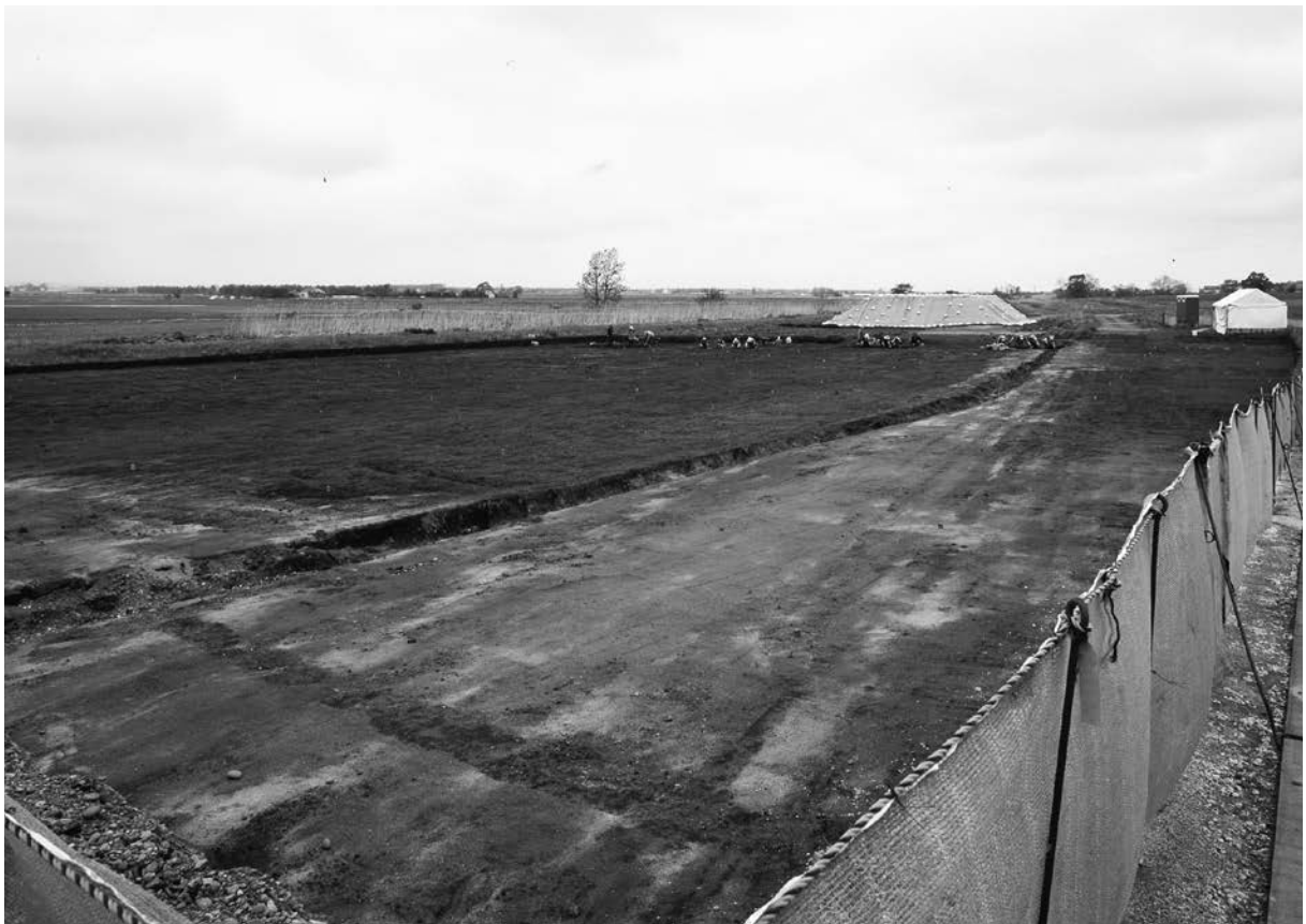
2 北側調査区調査状況
