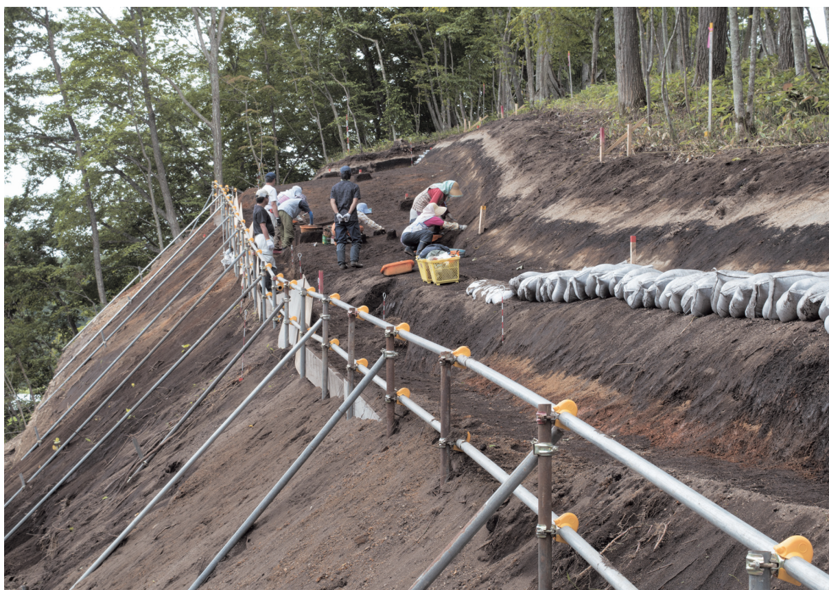
V層調査状況（西から）
